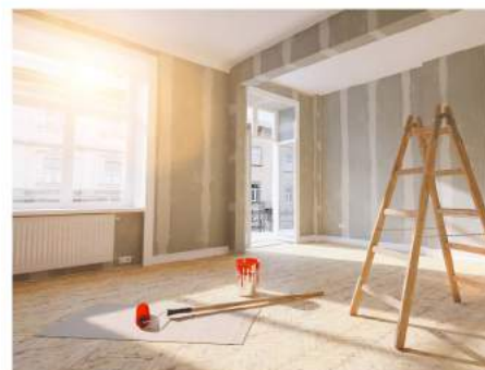
Obiekty modernizowane i remontowane
